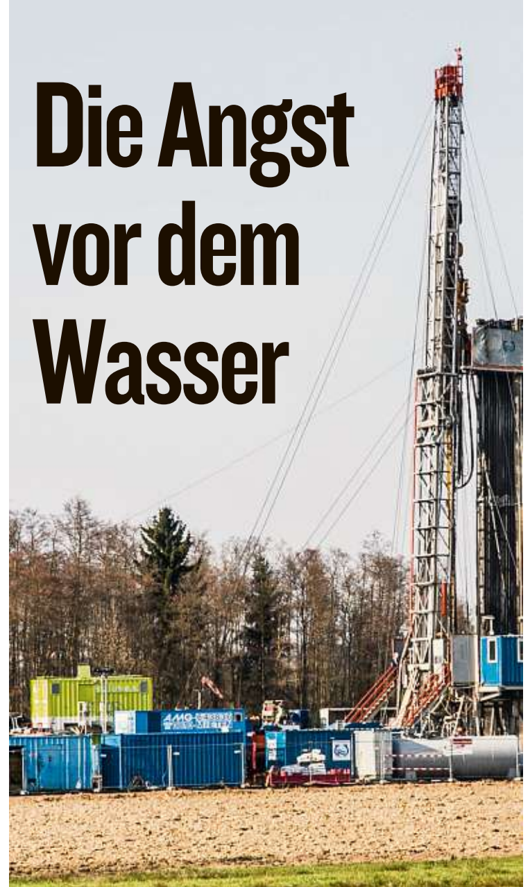
Nach der Probebohrung soll noch heuer mit dem Glashausbau begonnen werden
